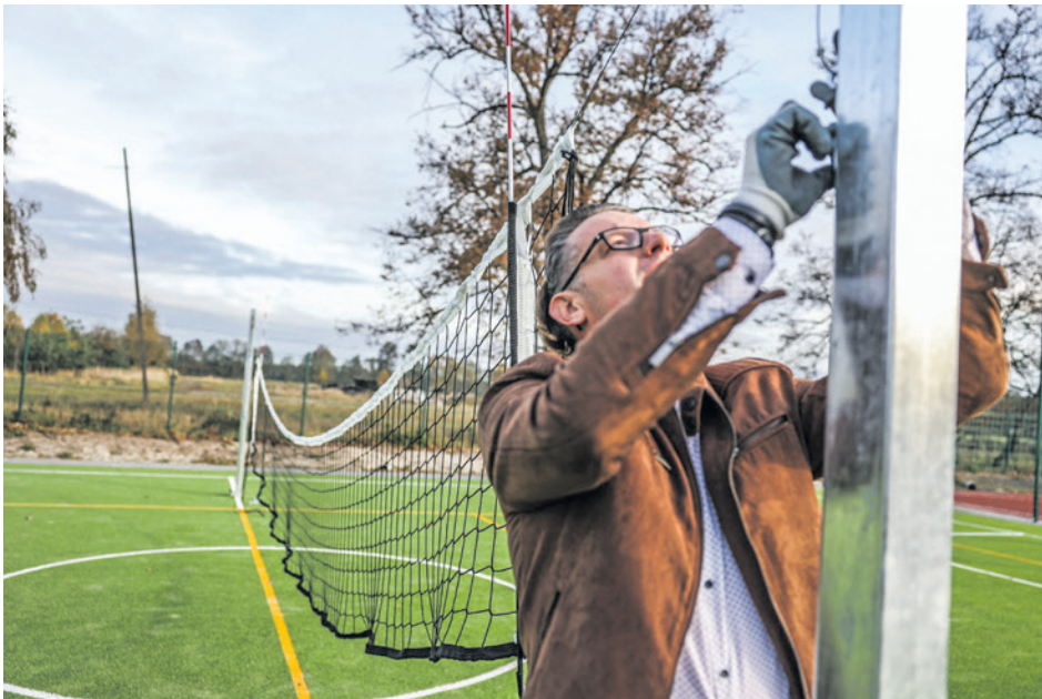
W minioną środę na boiskach w Jeleniowie zamontowano siatki i bramki. Na zdjęciu Łukasz Jarosz, przedstawiciel wykonawcy - firmy Mizar.
