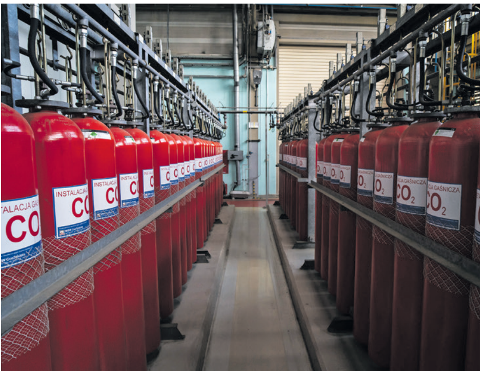
Obok turbos zespołu gazowego „Marian” ustawiono kilkadziesiąt butli z dwutlenkiem węgla. W przypadku pożaru turbos zespołu jest on wtłaczany do wnętrza, gasząc ogień.
