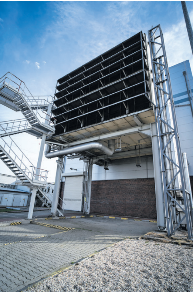
Gigantyczny filtr oczyszcza powietrze wprowadzane do turbiny. Jest tak dokładny, że w czasach przed pojawieniem się w mieście autobusów elektrycznych, wyłapywał zimną spalinę z pobliskiej zajezdni MZK.
