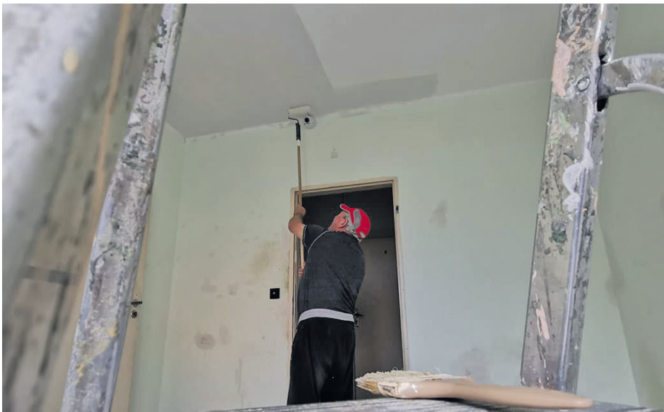
Z pomocą mieszkańców zostały wyremontowane wszystkie pokoje na piętrze budynku - sami je malowali
