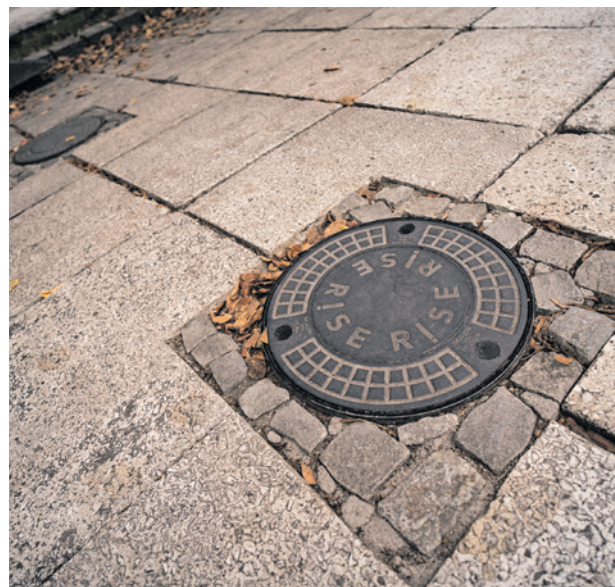
Słupki już schowane w nawierzchni starówki
