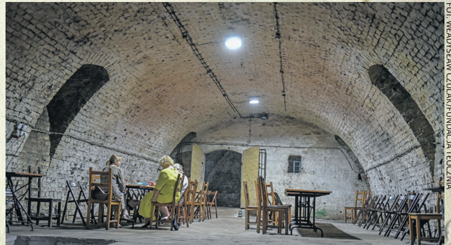
Wnęki w ścianach to otwory wentylacyjne - unikatowe rozwiązanie
