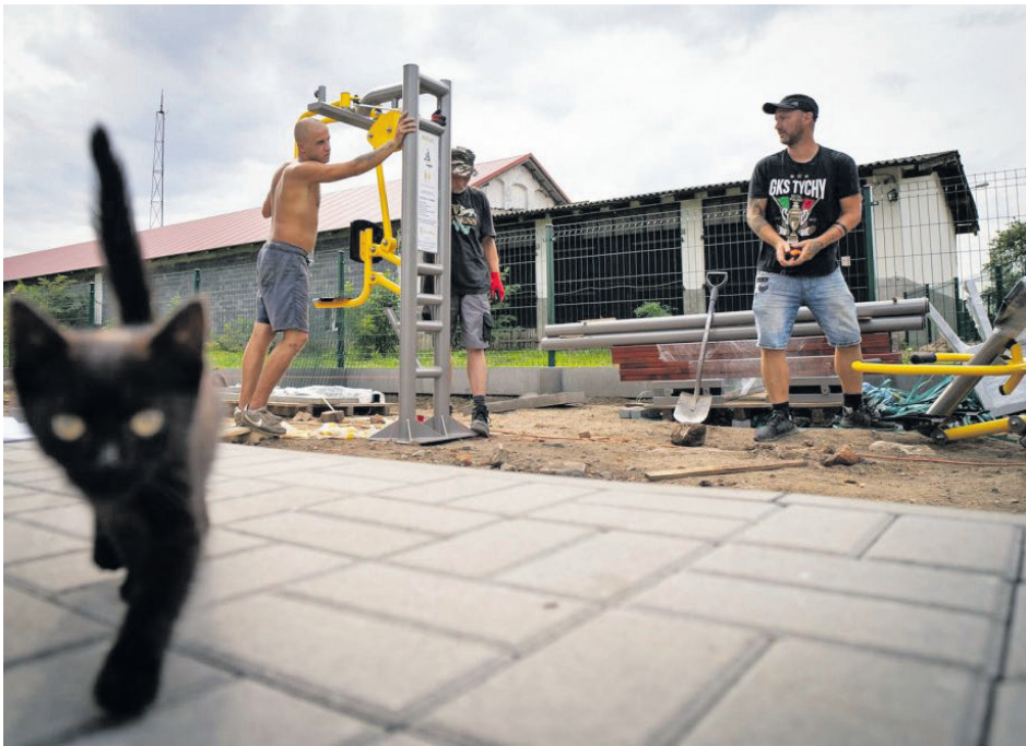
Trwa montaż siłowni plenerowej. Mieszkańcy będą mieli do dyspozycji osiem urządzeń. FOT. BARTOSZ MIROSLAWSKI
