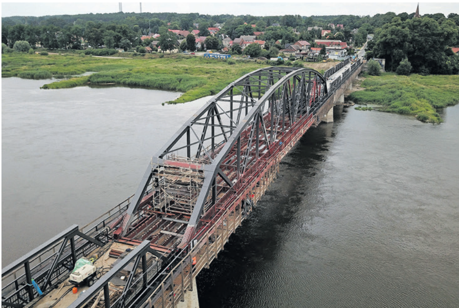
Teraz prace trwają na środkowym prześle nurtowym
