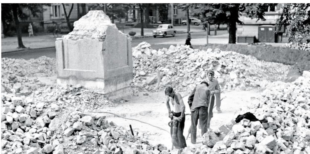
Czerwiec 1965 r. Robotnicy, przy pomocy młotów pneumatycznych, rozbijają resztki pomnika żołnierzy Armii Czerwonej, z którego pozostał jedynie niewielki cokół. FOT. BRONISŁAW BUGIEL
