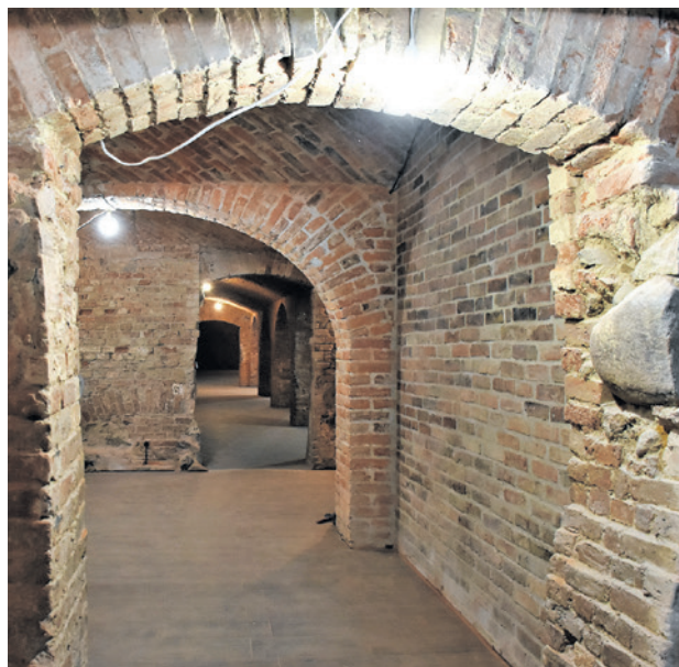
Do niedawna wejście było zalane betonem. Cała piwnica ma ok. 60 m długości.
