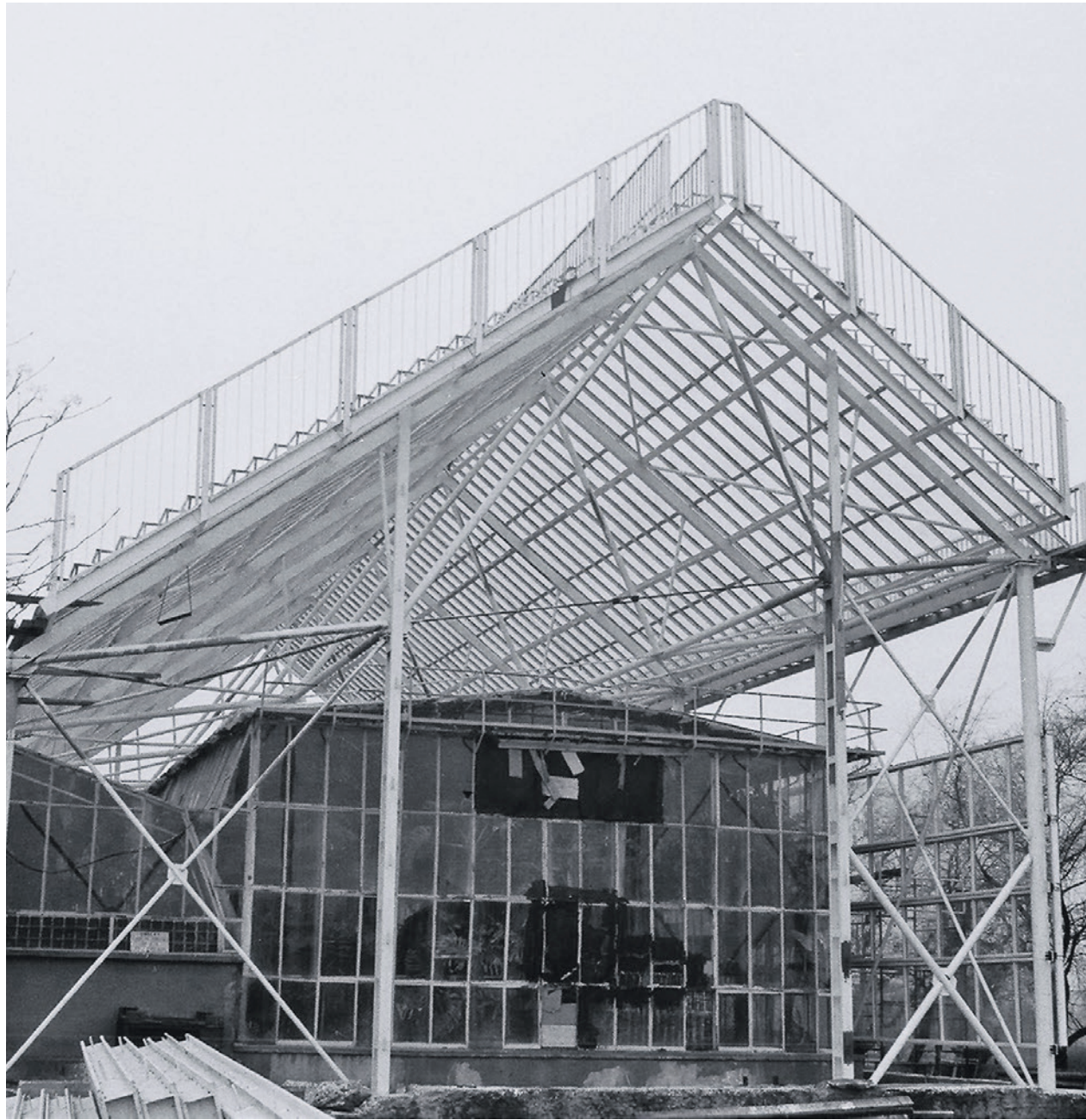
Nad starymi pawilonami ustawiono nową, wyższą konstrukcję
