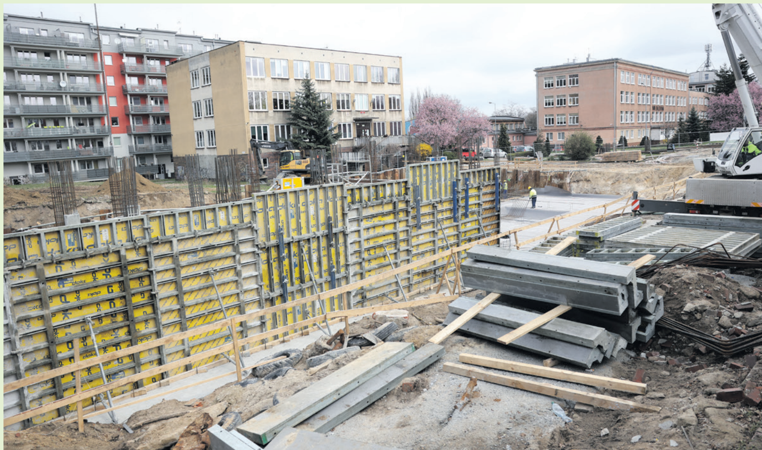
Wykonawcą jest firma LK Inwest z Wrocławia. Całe zadanie będzie kosztować około 35 mln zł. FOT. PIOTR JĘDZURA
