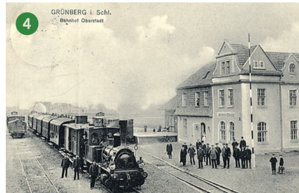
Dworzec Górne Miasto przy ul. Ogrodowej. Budynek stoi do dziś. ZE ZBIORÓW CZESŁAWA OSĘKOWSKIEGO
