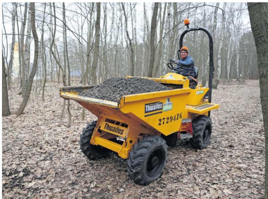
Piaszczyste podłoże nie wszędzie pozwoliło na formowanie nawierzchni trasy. Trzeba było nałożyć grubą warstwę kruszywa kamiennego. FOT. PIOTR JĘDZURA
