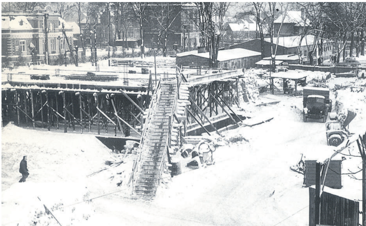
W 1967 r. stary dworzec został zburzony. Budowa nowego obiektu trwała trzy lata - został uroczystie otwarty 30 kwietnia 1970 r. FOT. BRONISŁAW BUGIEL
