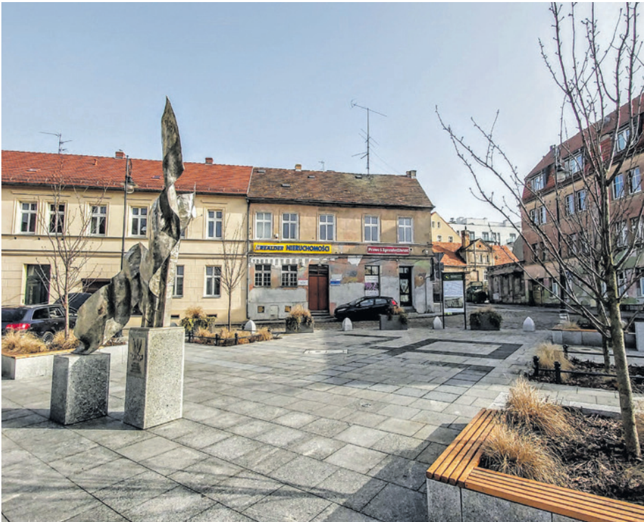
Kamienica przy pl. Matejki 7 stoi w sąsiedztwie już wyremontowanego budynku - gołym okiem widać między nimi różnicę FOT. TOMASZ CZYŹNIEWSKI
