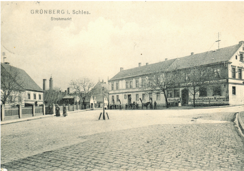
W XIX w. dzisiejszy pl. Matejki nazywano Rynkiem Słomianym. Tędy jechali goście. Tutaj zatrzymywali się, jedli i czasem spali. W 1900 r. działały tu dwie oberże: Pod Zielonym Drzewem i Pod Niemieckim Cesarzem. Budynki przetrwały do dziś. Zajazd Pod Niemieckim Cesarzem (na zdjęciu) zamykał plac od strony Parku Tysiąclecia. Jego właścicielem była Paula Schenk. Później oberżę przejęła rodzina Kummer. Najpierw Otto, po nim Berta. Po I wojnie światowej zmieniono nazwę lokalu na Ślaski Dom. ZE ZBIORÓW SŁAWOMIRA RONOWICZA
