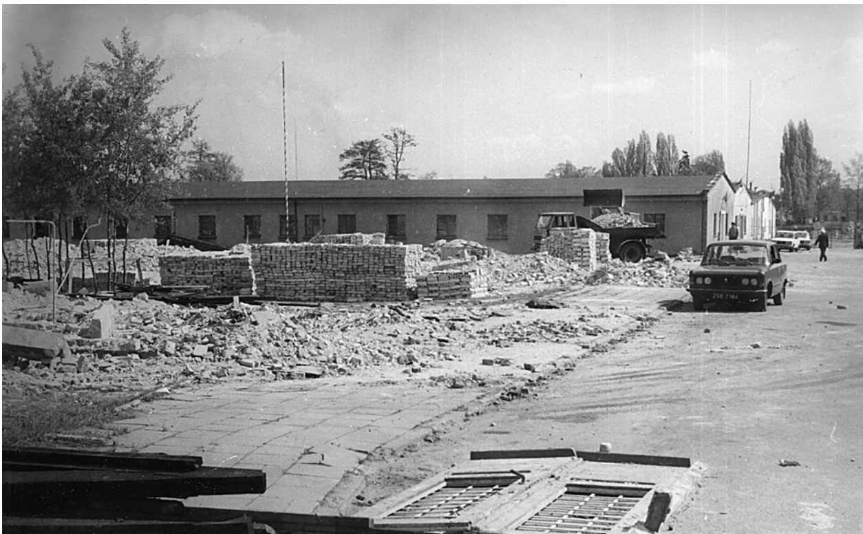
Maj 1988 r. Trwa rozbiórka części baraków. FOT. BRONISŁAW BUGIEL
