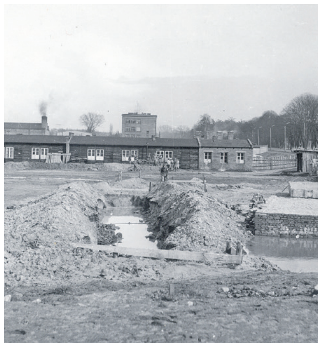
To samo miejsce kilka lat później - część baraków zburzono pod planowaną budowę pływalni FOT. BRONISŁAW BUGIEL
