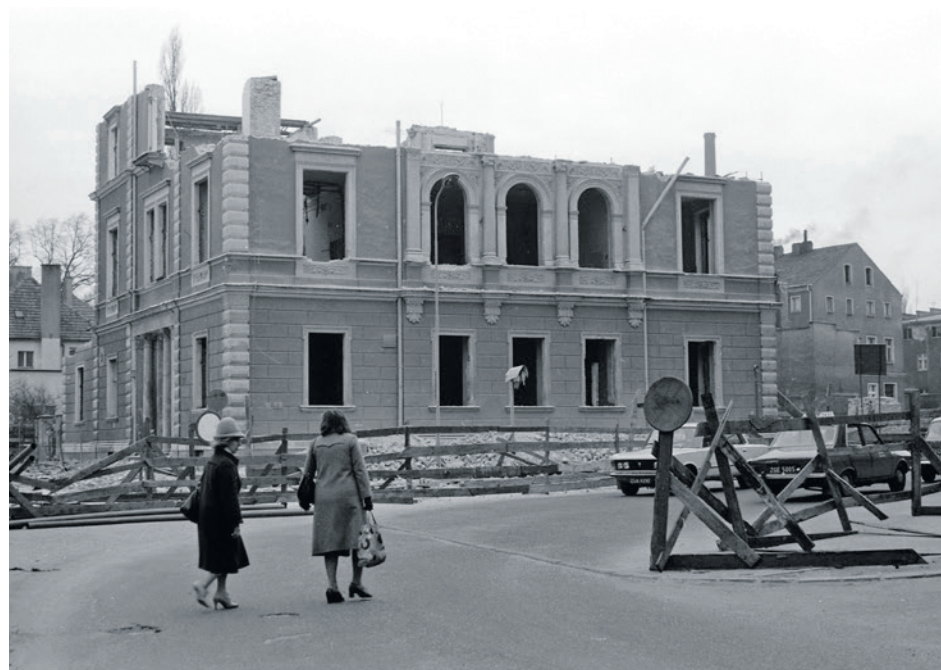
To samo miejsce i to samo ujęcie w 1982 r. Trwa już burzenie kamienicy – tędy pobiegnie al. Konstytucji 3 Maja. FOT. ZBIGNIEW RAJCHE
