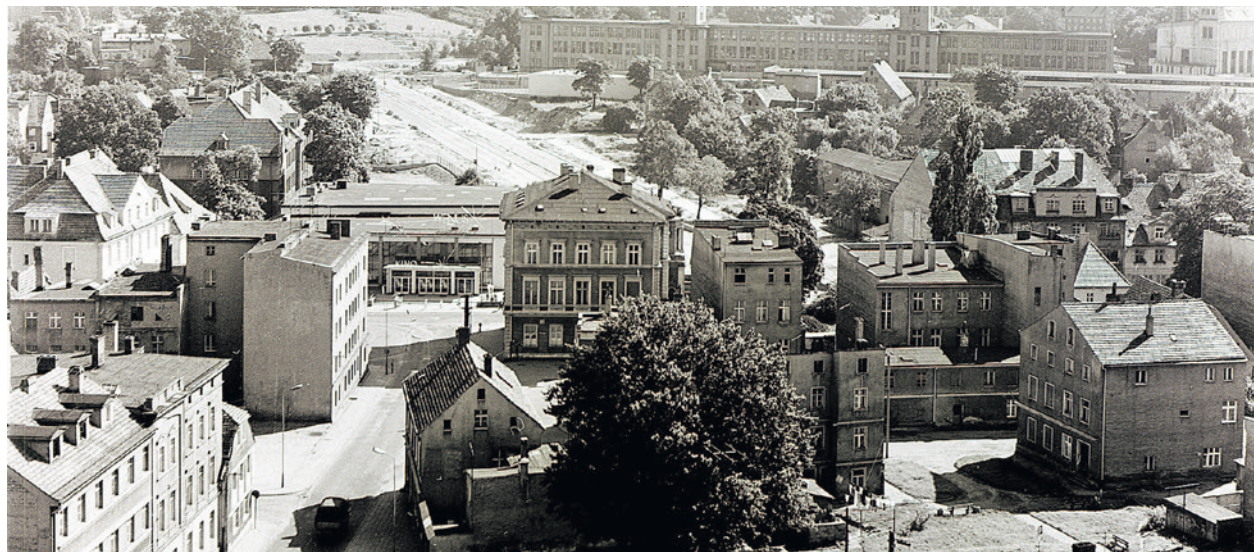
Podczas budowy al. Konstytucji 3 Maja projektanci mieli wybór: burzmy kino lub zabytkową willę. Zdecydowali się zostawić kino. Na zdjęciu część alei - od ul. Sikorskiego do Wrocławskiej - już powstaje. Fragment do ul. Długiej (dawna Srebrna Góra) trzeba będzie wyburzyć. FOT. CZESŁAW ŁUNIEWICZ
