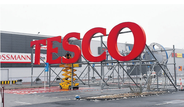
Z dachu budynku zniknął napis Tesco Extra. Z daleka nie wydawał się tak wielki, jak z perspektywy parkingu
