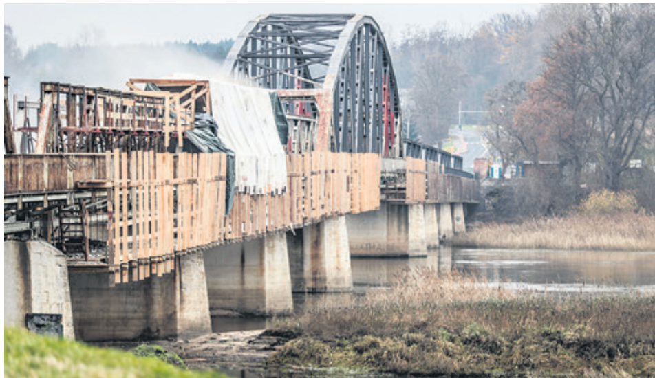
Most został oczyszczony z korozji, ma już za sobą m.in. piaskowanie i malowanie
