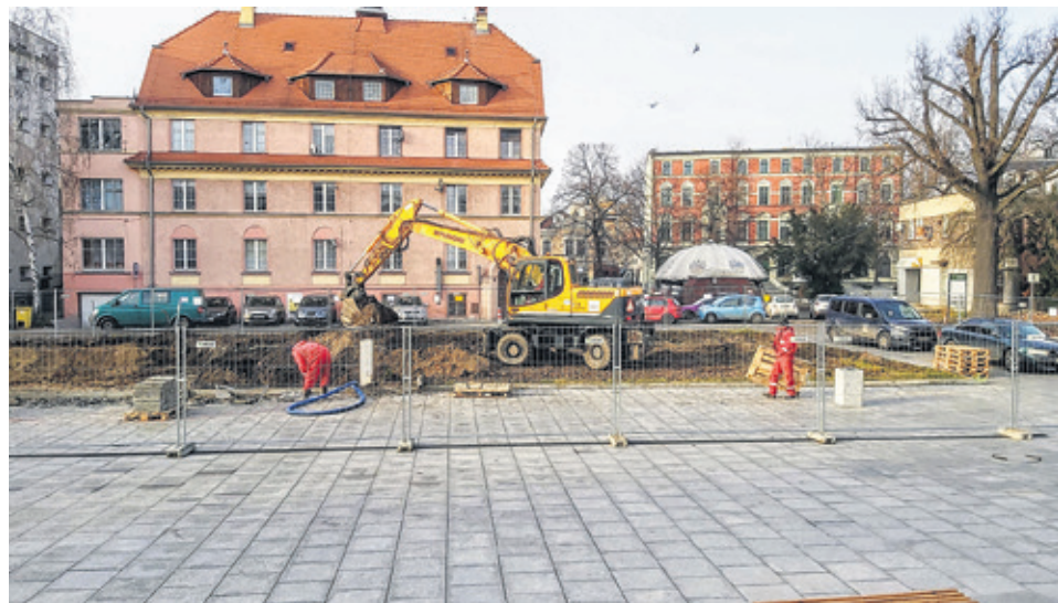
Na tyłach Lubuskiego Teatru praca wre, powstaje tam gratka dla najmłodszych - Teatr Lalek. Zadanie realizuje firma Exalo Drilling. Koszt inwestycji to około 15 mln zł.
