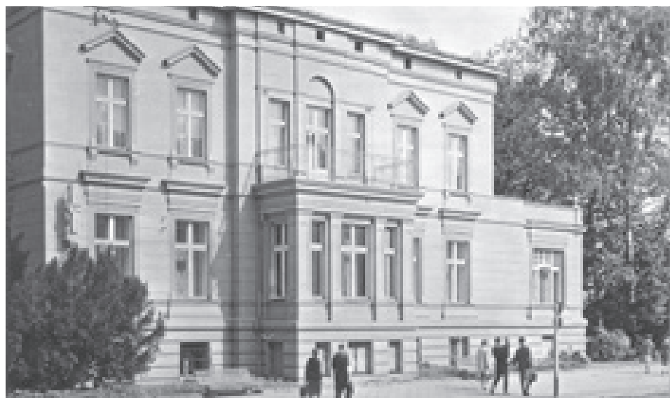
Podczas pożaru w grudniu 1958 r. zniszczeniu uległ strych. Już go nie odbudowano, budynek stracił wiele ozdób na elewacji. Ze zbiorów Tomasza Czyżniewskiego
