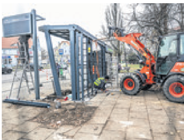
Zamontowano już konstrukcję pod zieloną ścianą na przystanku przy elżbietankach
