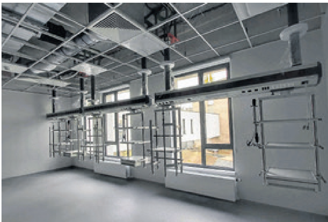
Ta sama sala - 16 listopada. Sprzętu jeszcze nie było, trwały prace przy instalacjach
