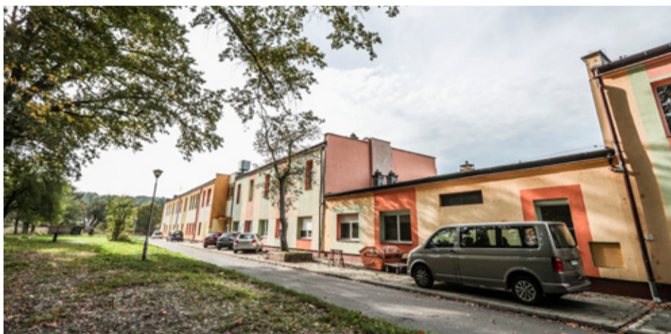
Na piętrze zaadoptowanego obiektu przy al. Wojska Polskiego obok Domu Samotnej Matki znalazłby się również Ośrodek Interwencji Kryzysowej Fot. Piotr Jędzura
