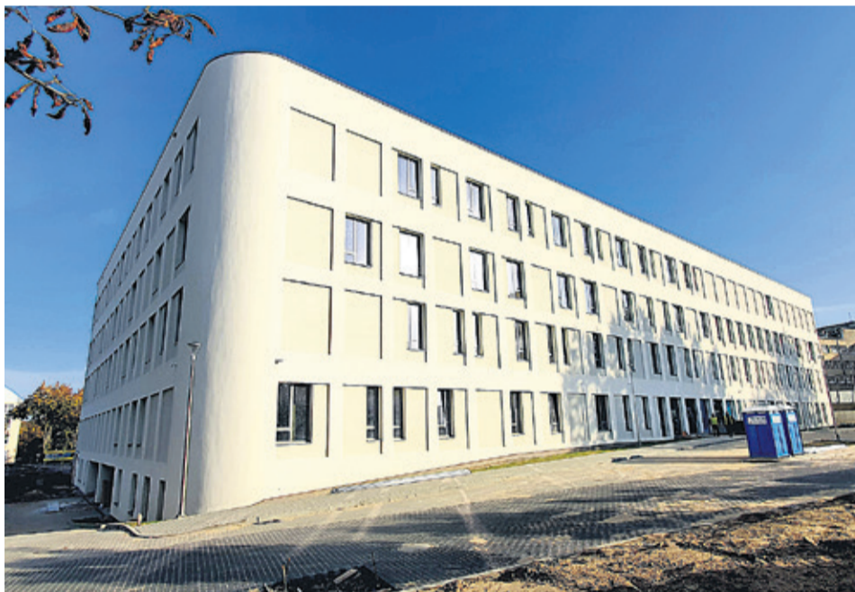
W szpitalu covidowym, który ma powstać w budowanym Centrum Zdrowia Matki i Dziecka będzie 150 łóżek, w tym 15 respiratorowych Fot. Igor Skrzyczewski
