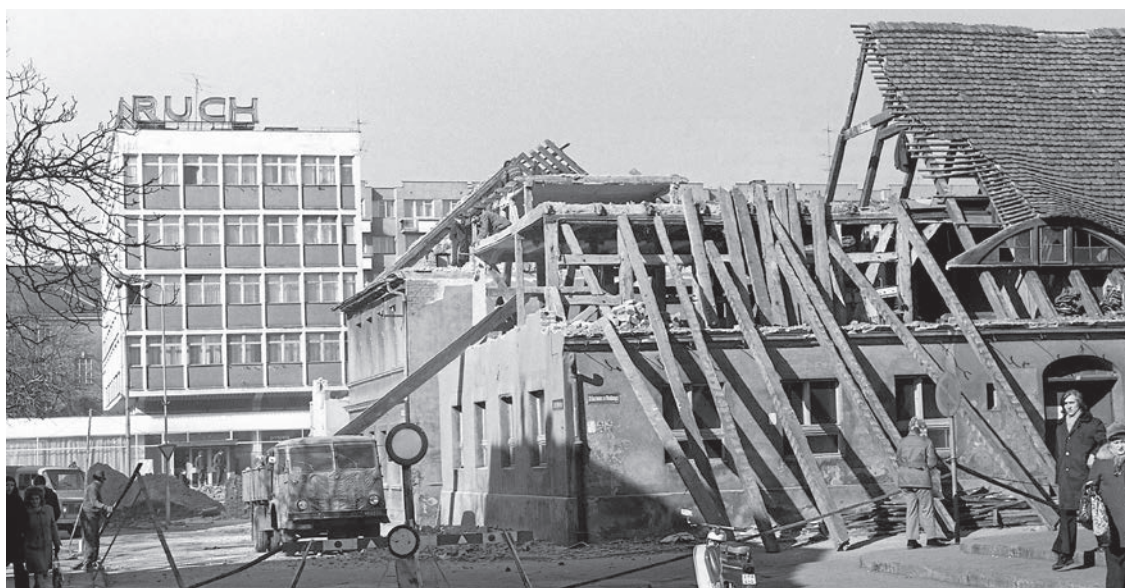
Rok 1974. Trwa wyburzanie domów pomiędzy ul. Kazimierza Wielkiego i Bohaterów Westerplatte
