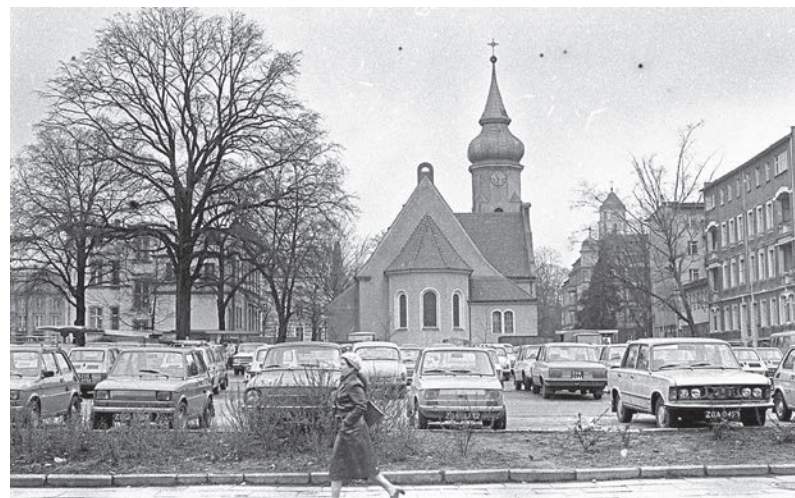
Po wyburzeniach w tym miejscu powstał parking
