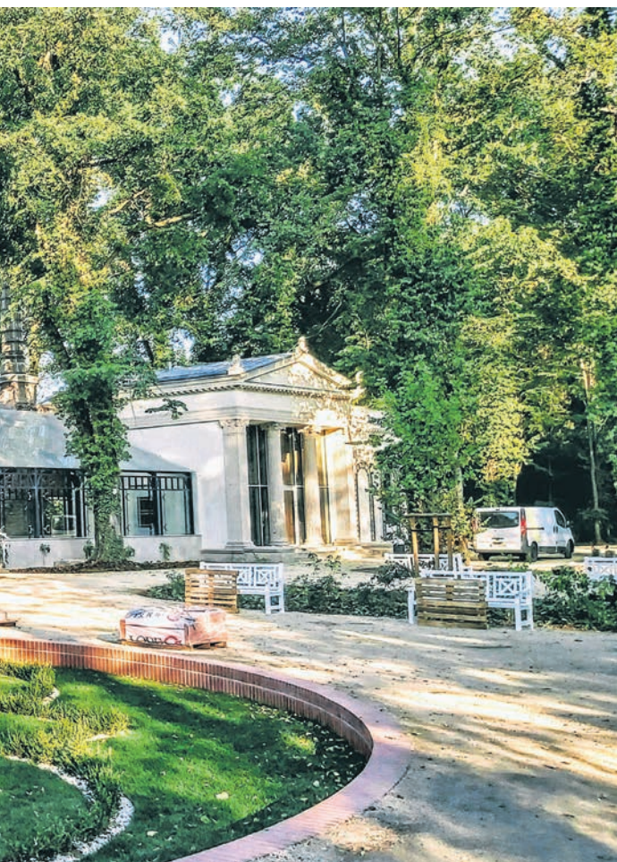
tacza świeży trawnik. Gotowy jest trejaż łączący pałac z oranżerią (po Fot. Tomasz Czyżniewski
