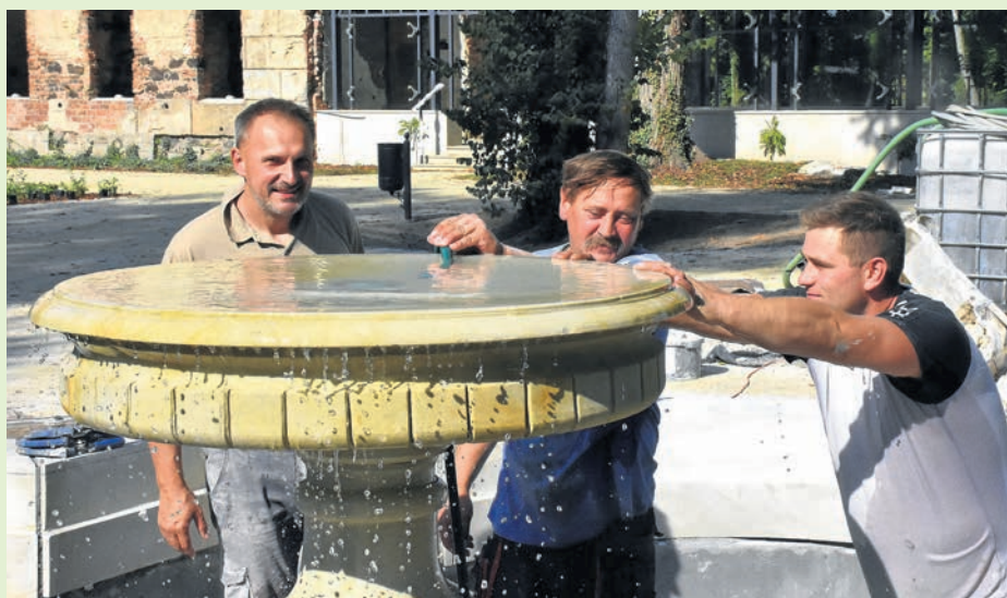
Tomasz Filar, Władysław Rogalski i Dawid Nowak pracują nad takim wypoziomowaniem misy fontanny, by woda wylewała się z niej równomiernie ze wszystkich stron
