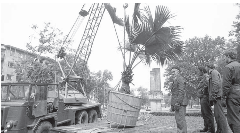
Palme trzeba było przenieść przy pomocy dźwigu
