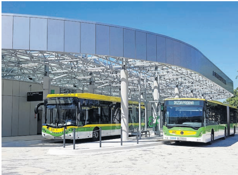
Budowa nowoczesnego centrum przesiadkowego i przebudowa układu komunikacyjnego kosztowała 39,9 mln zł
