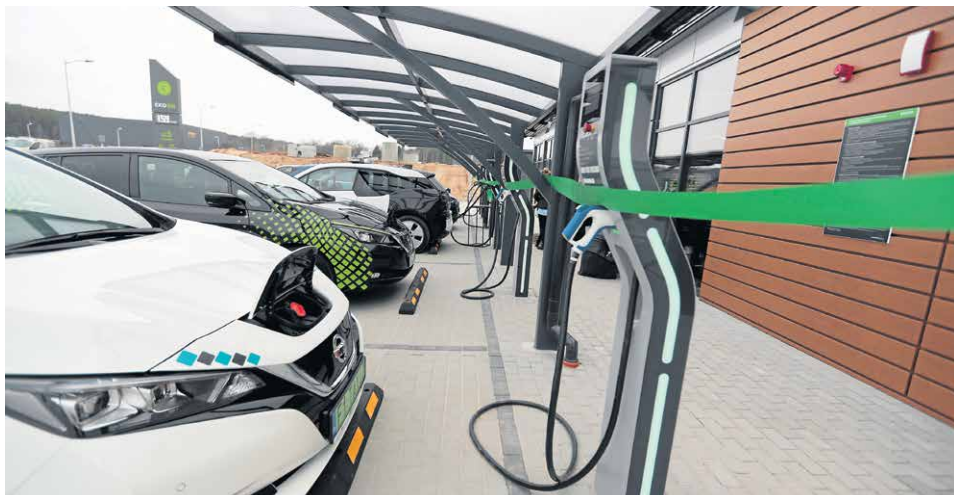
Zielonogórska stacja ładowania elektrycznych samochodów oferuje pięć stanowisk. Przecięt-ny czas ładowania to ok. 30 minut. Zdjęcia Piotr Jędzura
