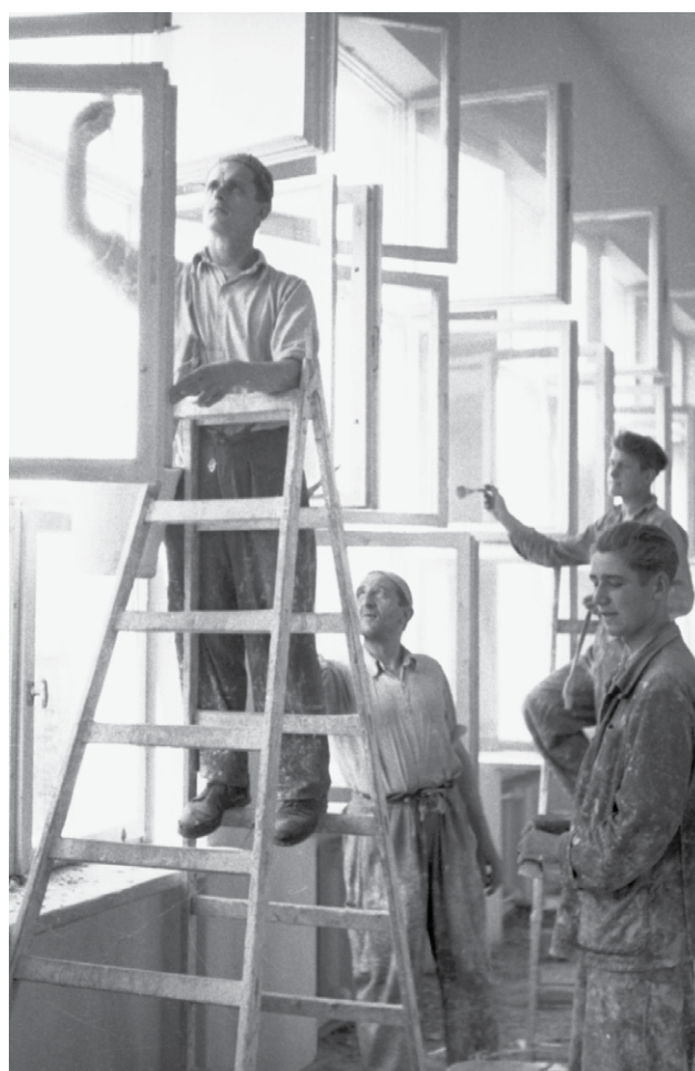
Trwają ostatnie prace wykończeniowe
