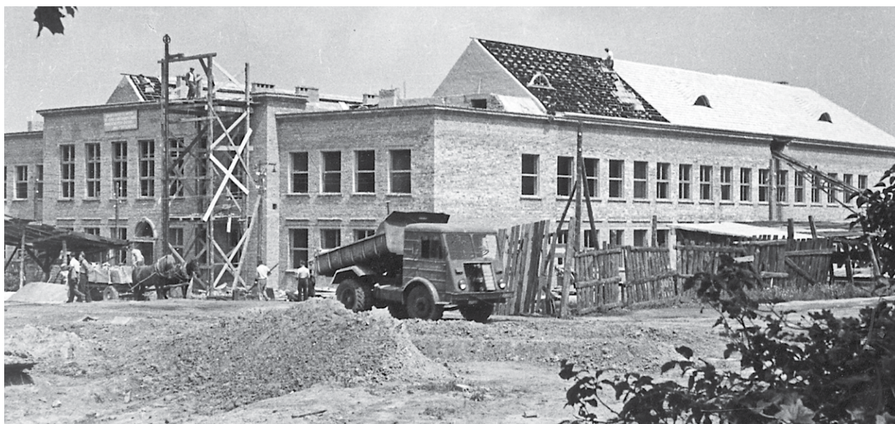
Rok 1955. Budowa szkoły przy ówczesnej ul. Pastuszej skrzyżowanie z ul. Kingi.
