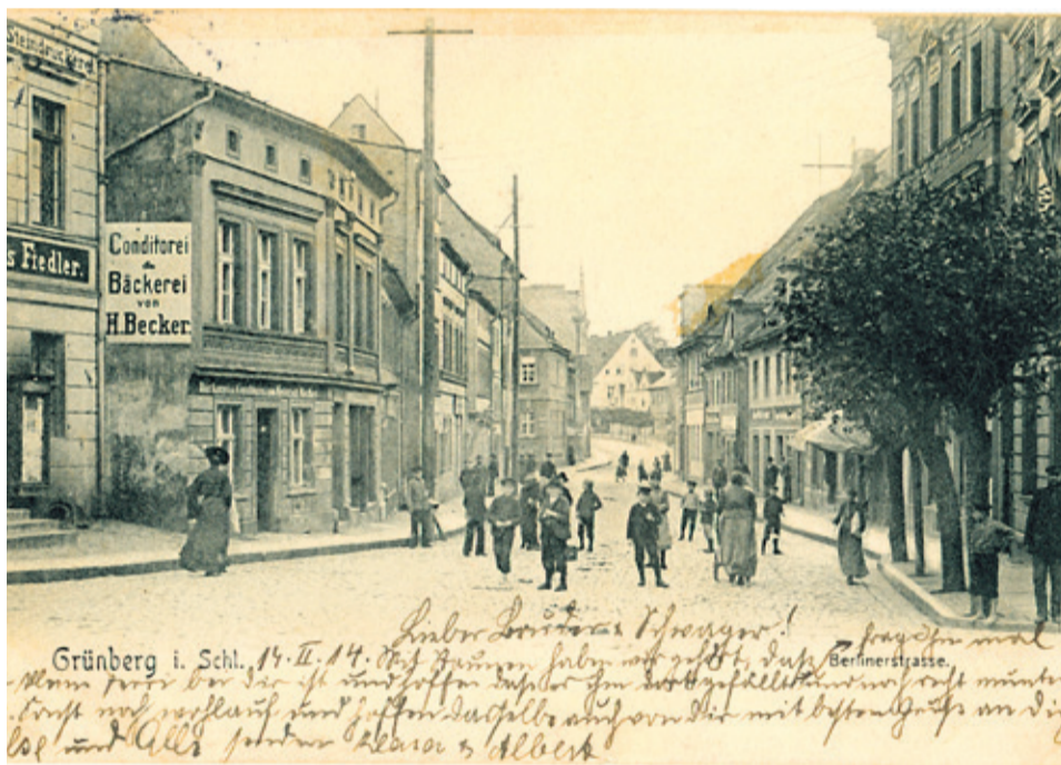
Berlinerstrasse, czyli dzisiejsza ul. Jedności w 1905 r. Fragment widziany od strony ul. Kasprowicza. Atelier fotograficzne Richarda Oye mieściło się na tyłach budynków - na zdjęciu po lewej stronie (koło drugiego słupa telegraficznego). Ze zbiorów Sławomira Ronowicza
