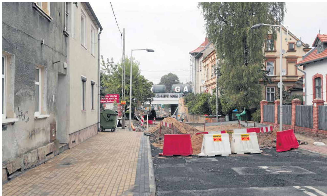
W połowie grudnia droga pod wiaduktem nad ul. Batorego ma być przejezdna
