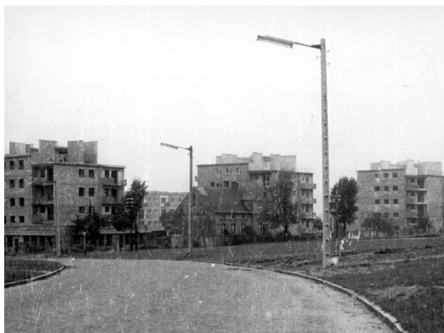
Narożnik ul. Waryńskiego - Podgórze. Trwa budowa.
