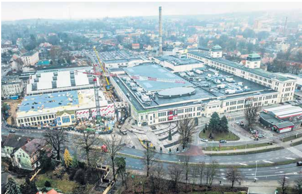
Patrzac z lotu ptaka - zamiast jeszcze niedawno ziejącej dziury - widać już dach, który osłoni przyszły parking (budynek po lewej stronie) Fot. Piotr Jędzura
