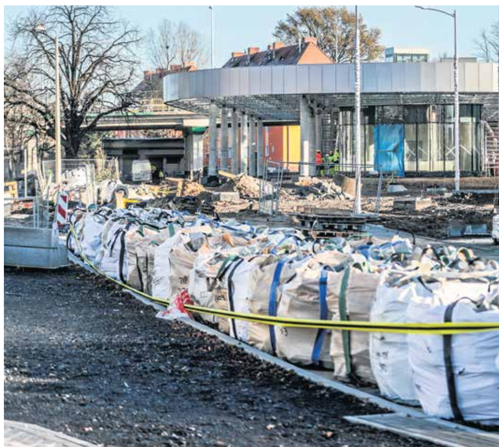
Konstrukcja centrum przesiadkowego jest już gotowa. Błyskawicznie zmienia się otoczenie budynku.
