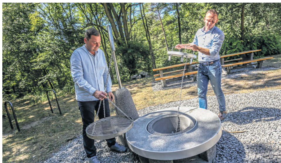
Podstawa grilla jest betonowa, palenisko stalowe – pokazują Grzegorz Hryniewicz i Paweł Wysocki Fot. Piotr Jędzura
