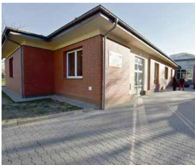
Nowe, rozległe skrzydło powstało w miejscu rozebranej do fundamentów przestarzałej części obiektu
