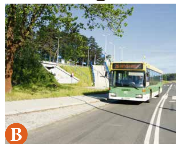
W parku jest pętla MKZ umiejscowiona obok peronu kolejowego
