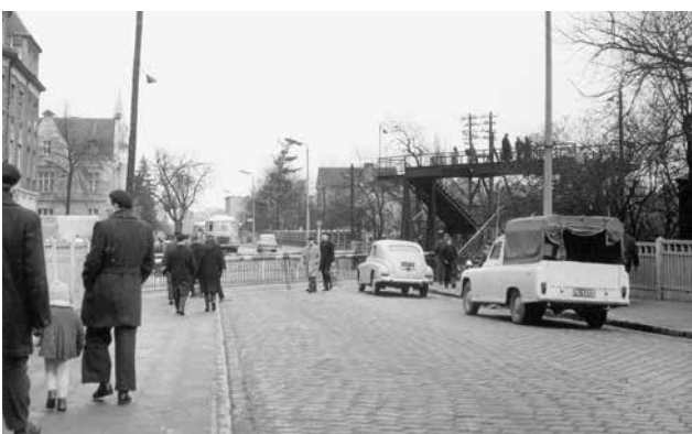
Przejazd kolejowy na ul. Sulechowskiej i kładka nad torami. Fot. Bronisław Bugiel
