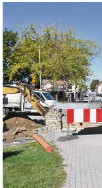
Ul. Aglomeracyjna połączy ul. Batorego z al. Zjednoczenia. W ramach nowego rondem na ul. Zjednoczenia Borchers na skrzyżowaniu ul. Batorego z al. Zjednoczenia. Termin zakończenia robót
