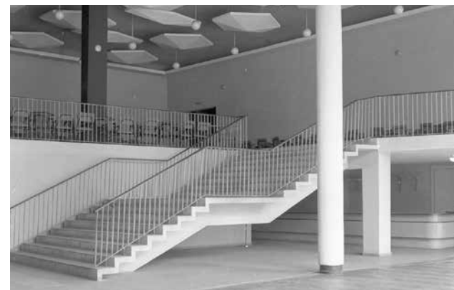
W połowie lat 60. przebudowano hol budynku
