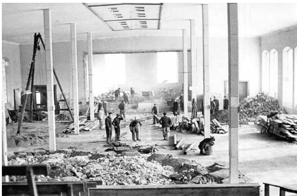
Rok 1957. Remont wnętrza Hali Ludowej. Jeszcze stoją przedwojenne słupy.
