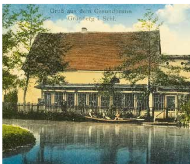
STAW PRZY UL. ŹRÓDLANEJ 3 Nie ma po nim śladu.
