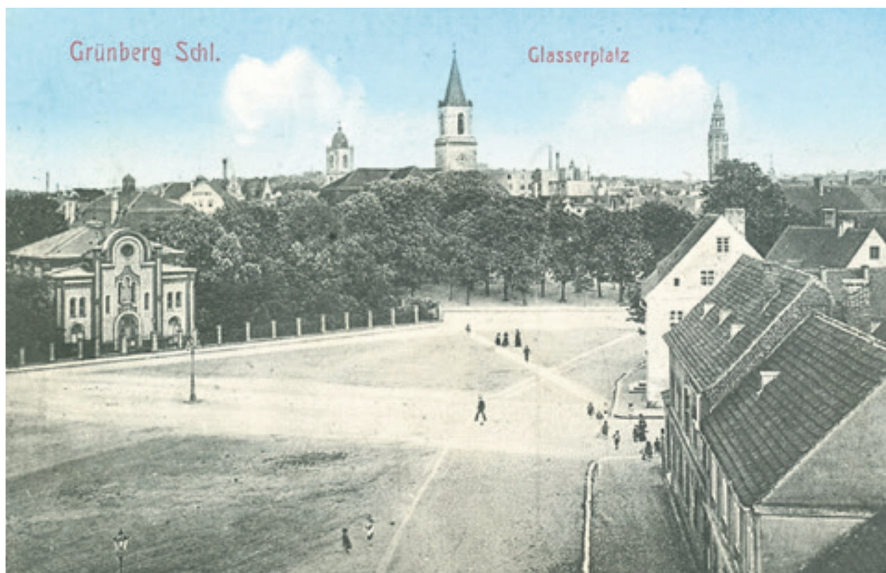
Widok z lotu ptaka na pl. Powstańców Wielkopolskich i synagogę
