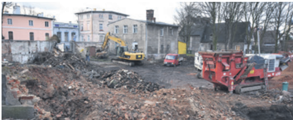
W drugim tygodniu kruszenia pozostałości po byłym budynku LOK, teren przypominał plan wojennego filmu. Na szczęście, prace idą szybko, „straszenie” przechodniów nie potrwa zbyt długo.
