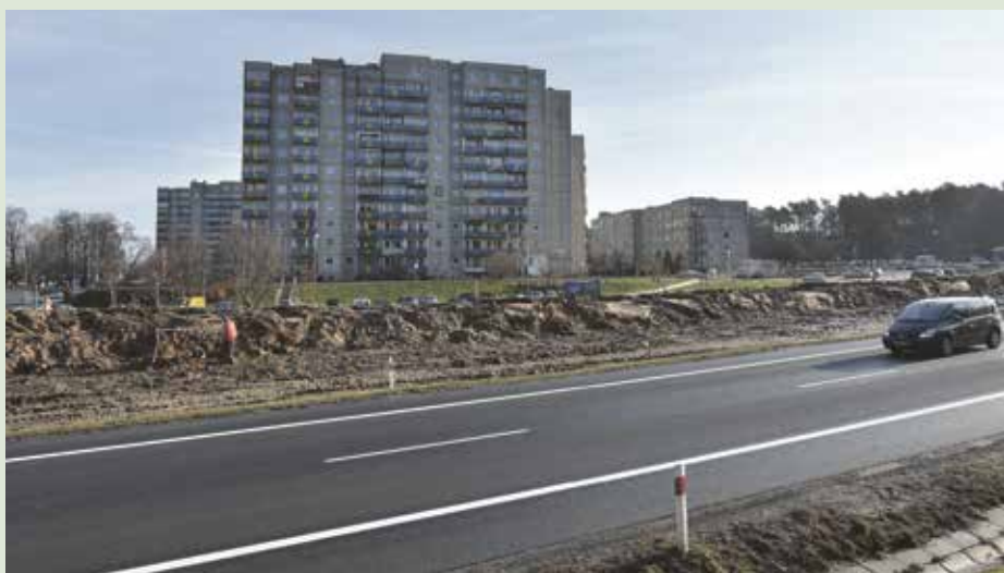
Nowe ekrany akustyczne, przy os. Pomorskim, zobaczymy prawdopodobnie w 2017 r. Ostateczny termin zależy od wykonawcy kontraktu.
