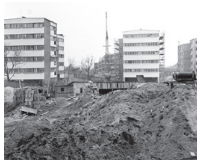
Obok trwała wielka budowa osiedla mieszkaniowego
