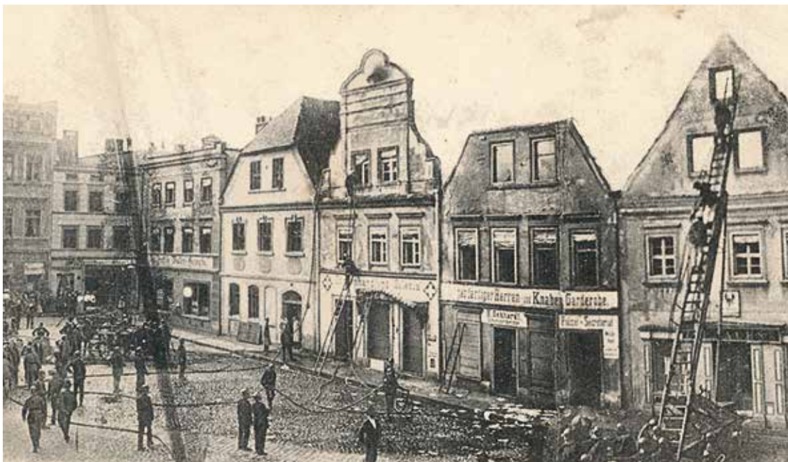
18 sierpnia 1903 r. Pożar wybuchł ok. godz. 14.30. Trzy budynki uległy takiemu zniszczeniu, że trzeba było je zburzyć
