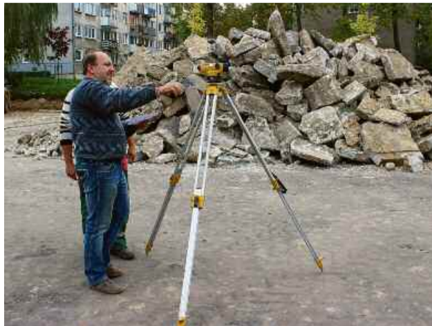
- Zgodnie z projektem zostawimy płytę boiska. Położymy na nią 15-centymetrową warstwę kruszywa - zapowiada Marek Przybylski, właściciel firmy Spiraea. Fot. Krzysztof Grabowski
