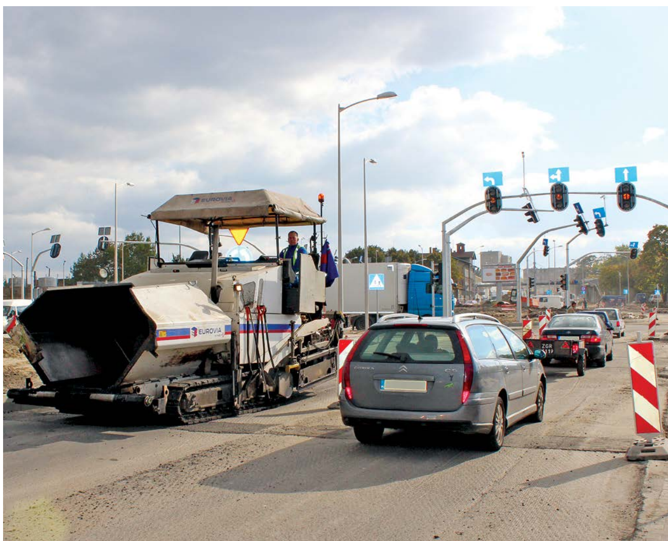
Na rondzie PCK wreszcie widać ruch. Do pracy przystąpiła firma Eurovia.
