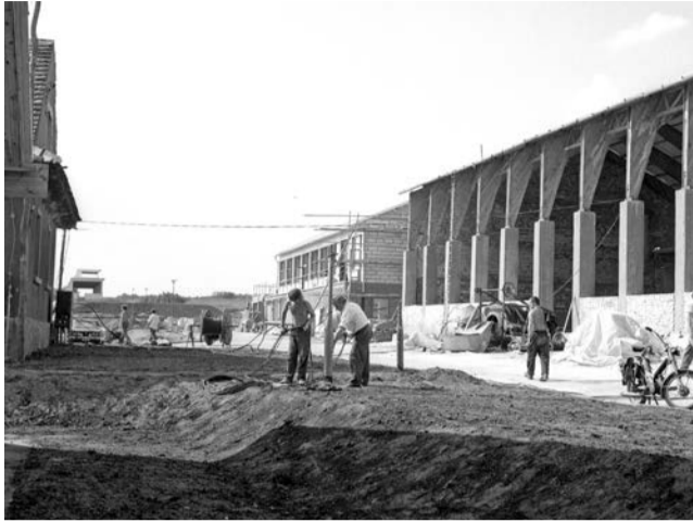
Sierpień 1976 r. – budowa ośrodka
