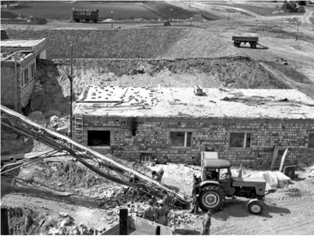
Sierpień 1976 r. – budowa ośrodka
