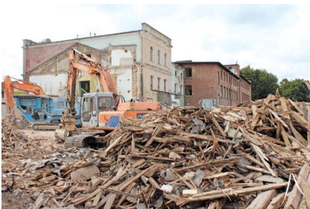
Pusto robi się przy ul. Dąbrowskiego... Firma Skanska wyburza dawny budynek Lumelu. Powstanie tu Centrum Przyrodnicze.
