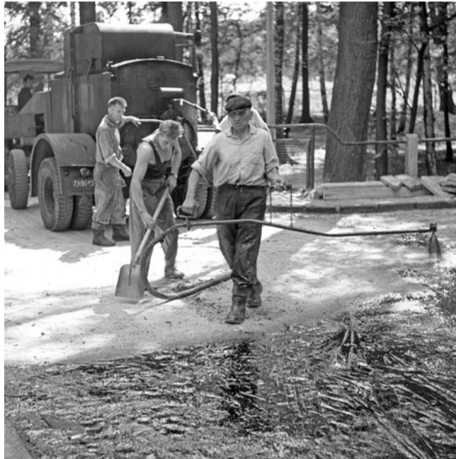
Prace drogowe, robotnicy nakładają nawierzchnię ze smoły Fot. Bronisław Bugiel
