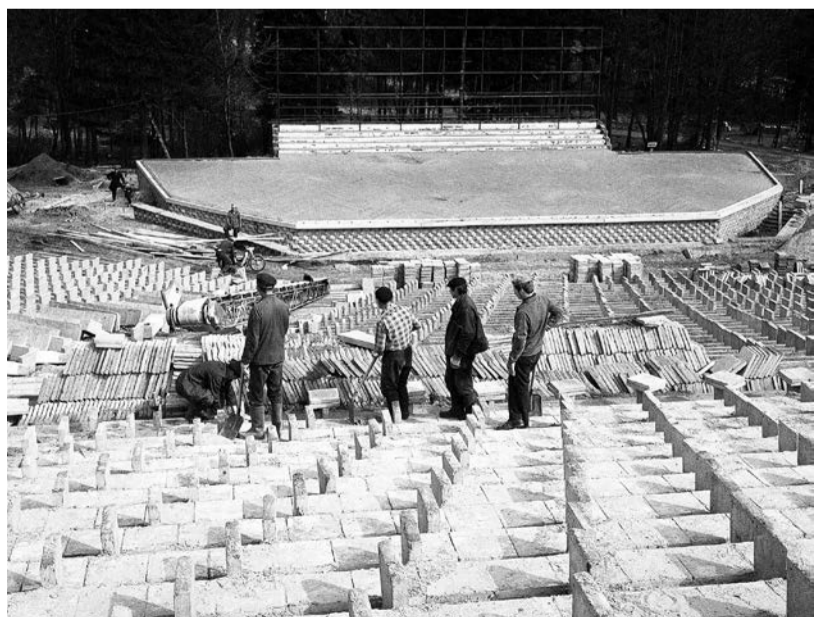
Marzec 1973 r. – trwa budowa nowego amfiteatru
