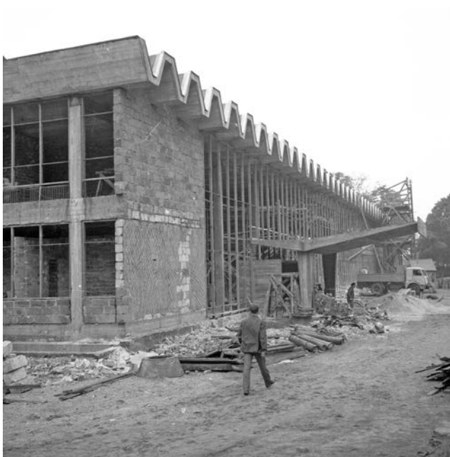
Budowa nowego dworca
