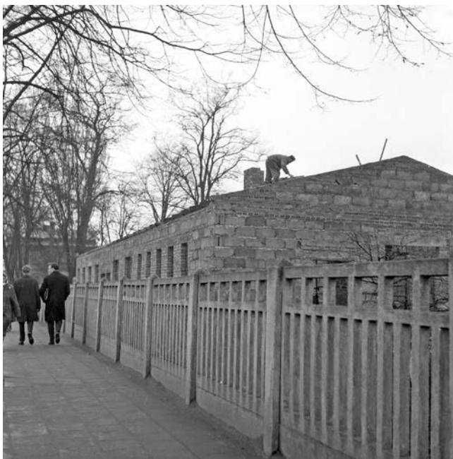
Robotnicy stawiają barak, w którym będą tymczasowe kasy biletowe
