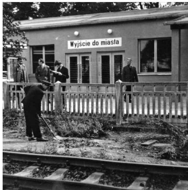
Tymczasowy dworzec – wejście od strony peronów
