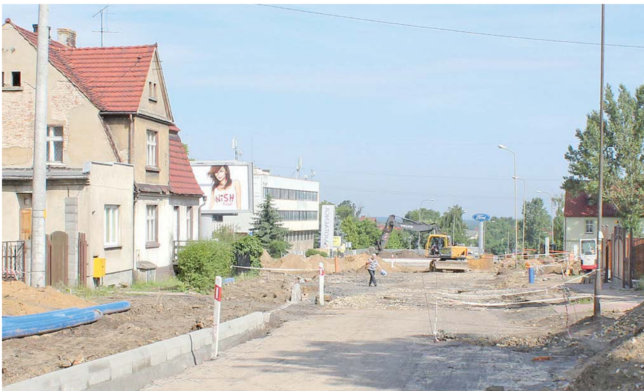
Widok współczesny. Właśnie trwają prace przy budowie ronda
