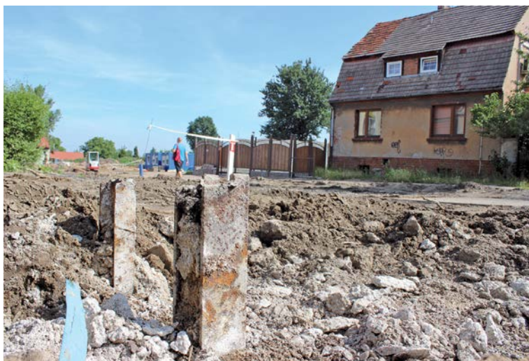
Resztki stalowych belek z zapory
