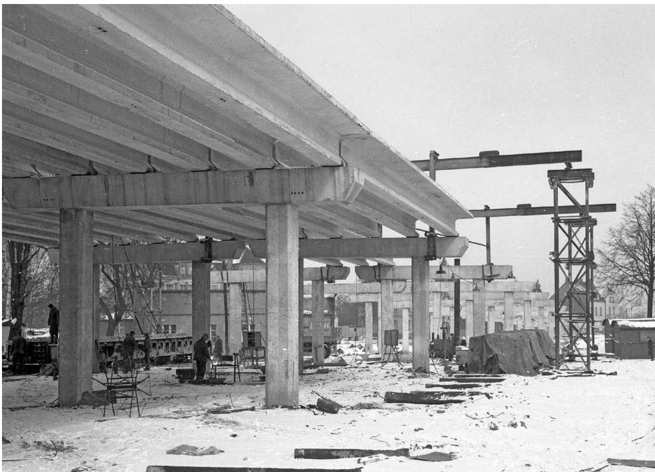
Trwa budowa wiaduktu nad torami z ul. Wyspiańskiego n ul. Sulechowską
