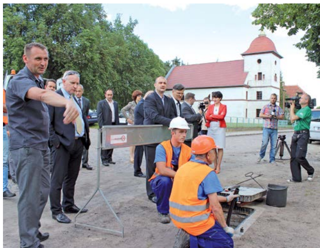
Kulminacyjnym punktem spotkania było „wdmuchiwanie” w izolacyjną osłonę wcześniej „zespawanego”, niewiele grubszego od włosa, światłowodu
