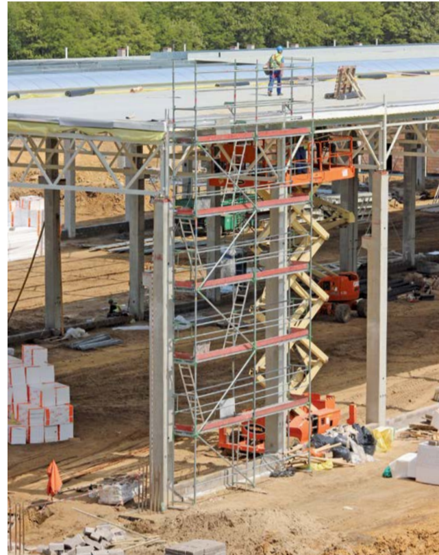
Na budowie robotnicy właśnie kładą dach i montują ściany
