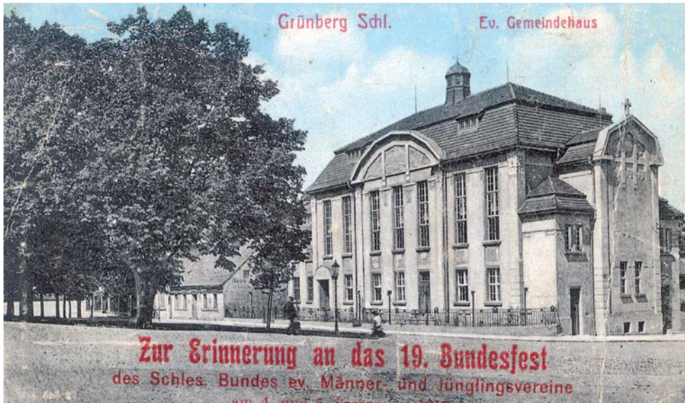
Budynek filharmonii to dawny dom parafialny wspólnoty ewangelickiej, przy dzisiejszym kościele Matki Bożej Częstochowskiej. Zbudowany został w 1909 r. Katolicy przejęli go wraz ze świątynią w grudniu 1945 r.
